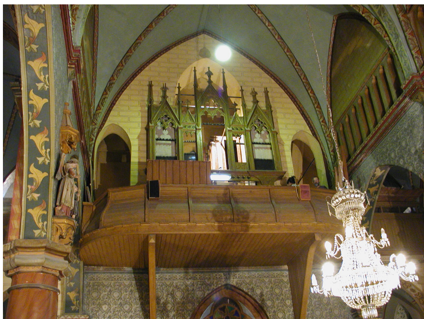
Проспектът по време на ремонта
